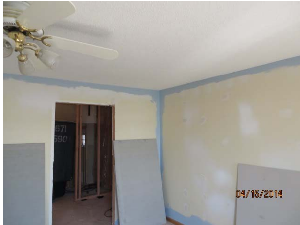
PC 19) View of demo / drywall repairs
