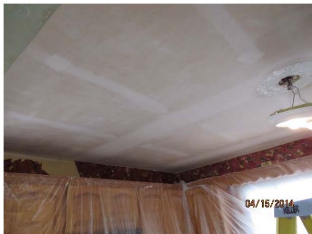
PIC 23) View of demo / drywall repairs
