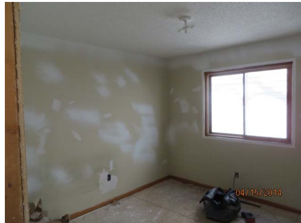
PIC 34) View of demo / drywall repairs
